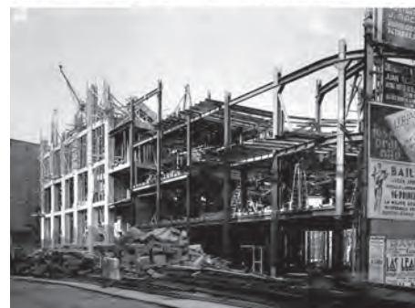
30 Armaduras de vigas de hormigón.
