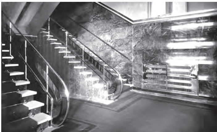
49 Diseño de la barandilla de la escalera.
