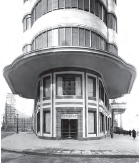
46 Marquesina del vestíbulo de las taquillas.
