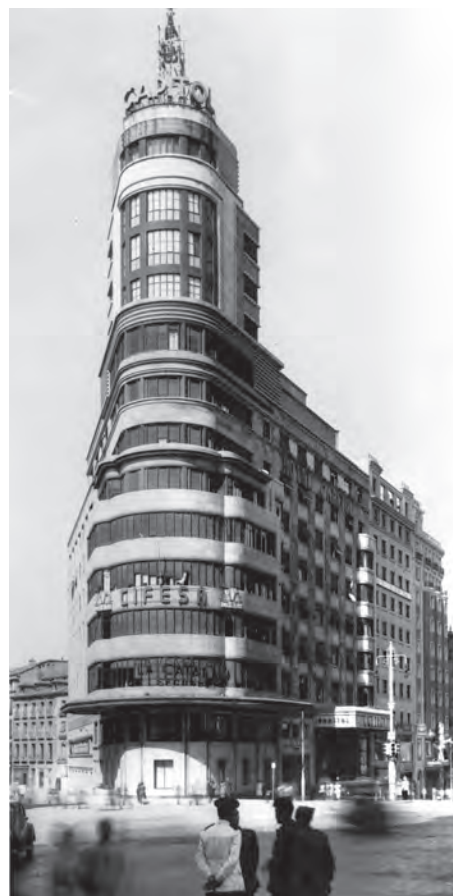
1 El edificio Carrión recién terminado.
