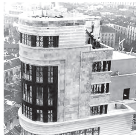
35 Torreón en construcción.
