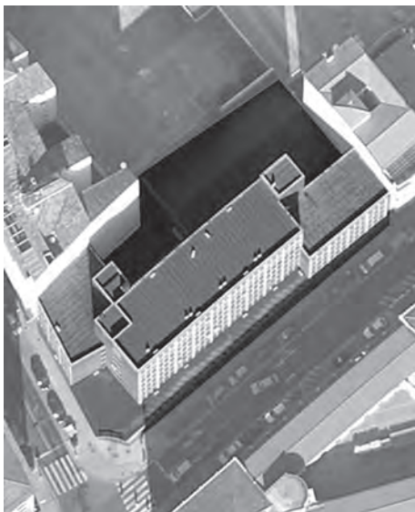
2 Julio González, Equipamientos y sede de Sindicatos . Valladolid (1959). Vista aérea [Foto: Daniel Villalobos Alonso]
