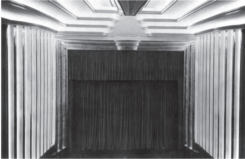
27 Vista interior del escenario con tratamiento de techo y paredes acústicas.
